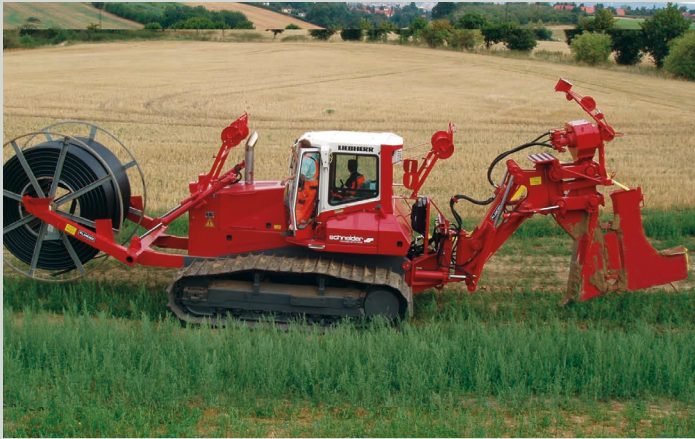
KV 15 - mit Liebherr Planierraupen / with Liebherr crawler
